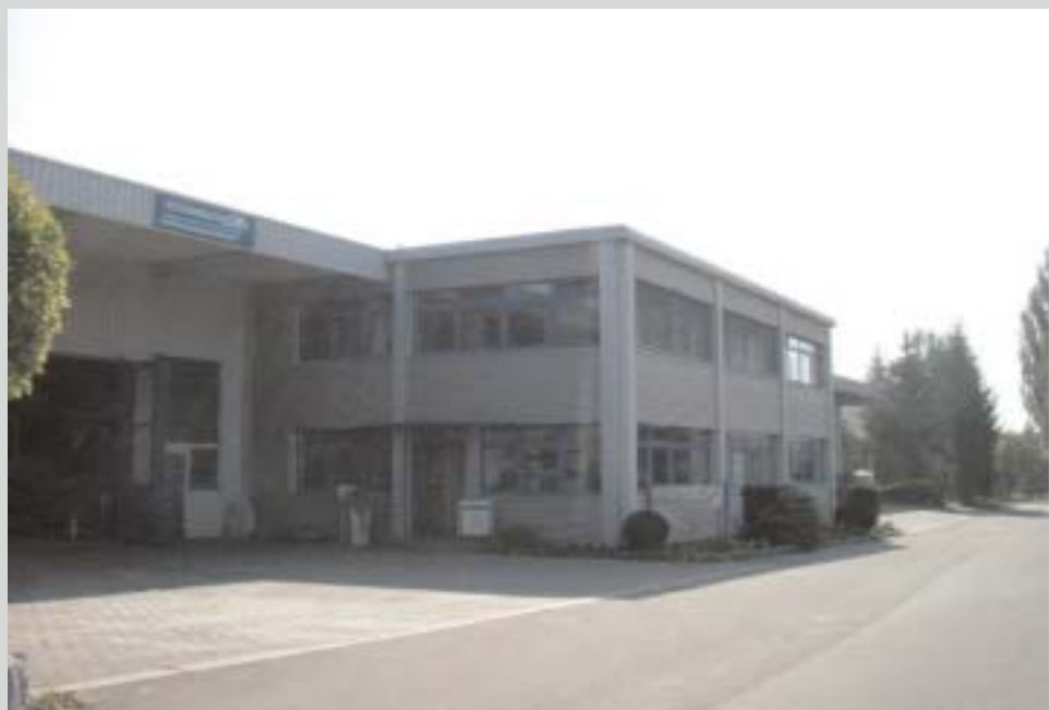
Die Lager- und Produktionshalle.
